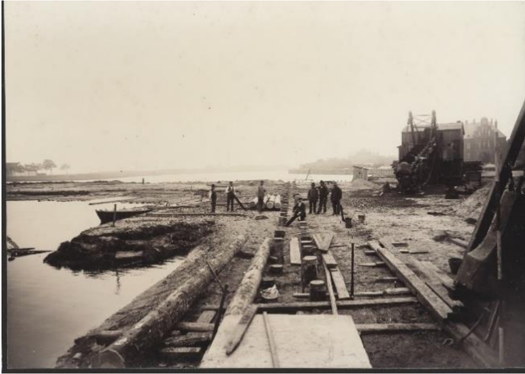
Abb. 57: Der Alte Strom wird nahe dem Zollamt zugeschüttet
