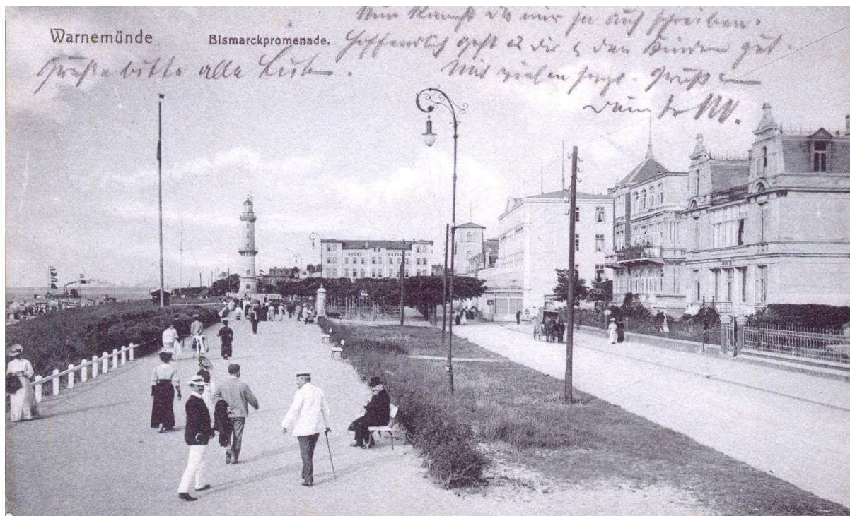
Abb. 33: Elektrische Stadtbeleuchtung Bismarckpromenade
