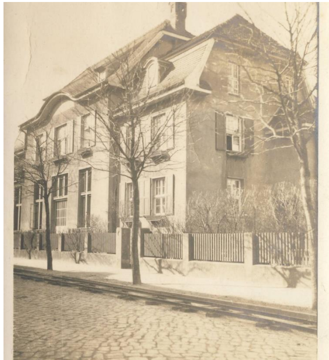
Abb. 79: Die Unterstation Warnemünde des E-Werkes Rostock-Bramow in der Dänischen Straße
