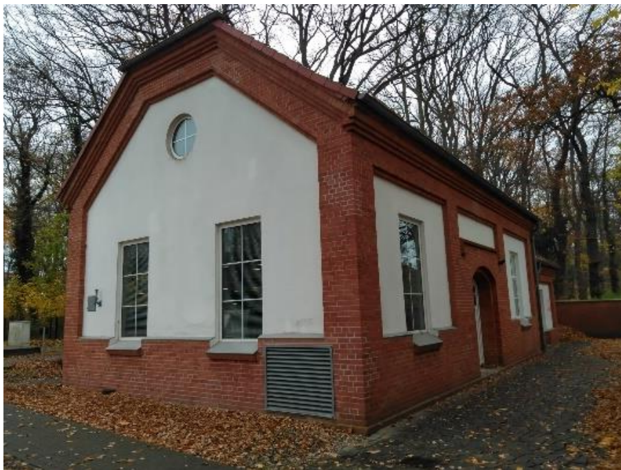
Abb. 74: Das alte Pumpwerk in der Parkstraße
