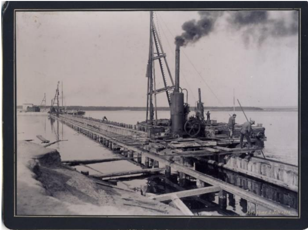
Abb. 51: Dampfbramme beim Molenbau, verarbeitet wird Pitchpine- Holz aus Florida
