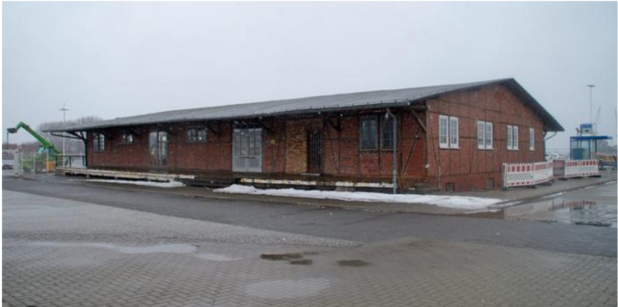
Abb. 72: Der Zucker-/Zwiebelschuppen kurz vor dem Abriss 2016
