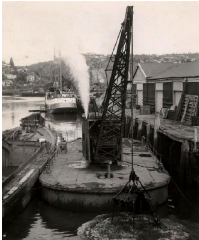
Abb. 20: Schwimmbagger mit Greifer, sog. „Priestmannscher Elevator“
