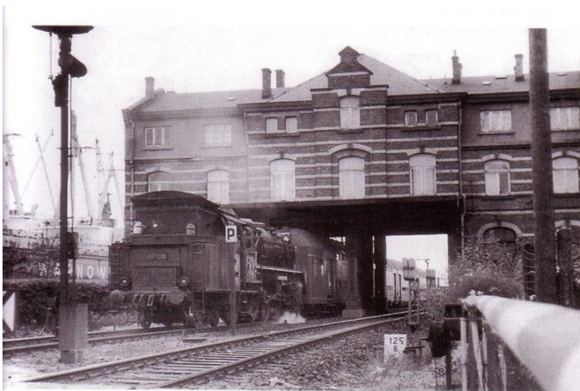
Abb. 59: Das alte Empfangsgebäude nach dem Durchbruch
