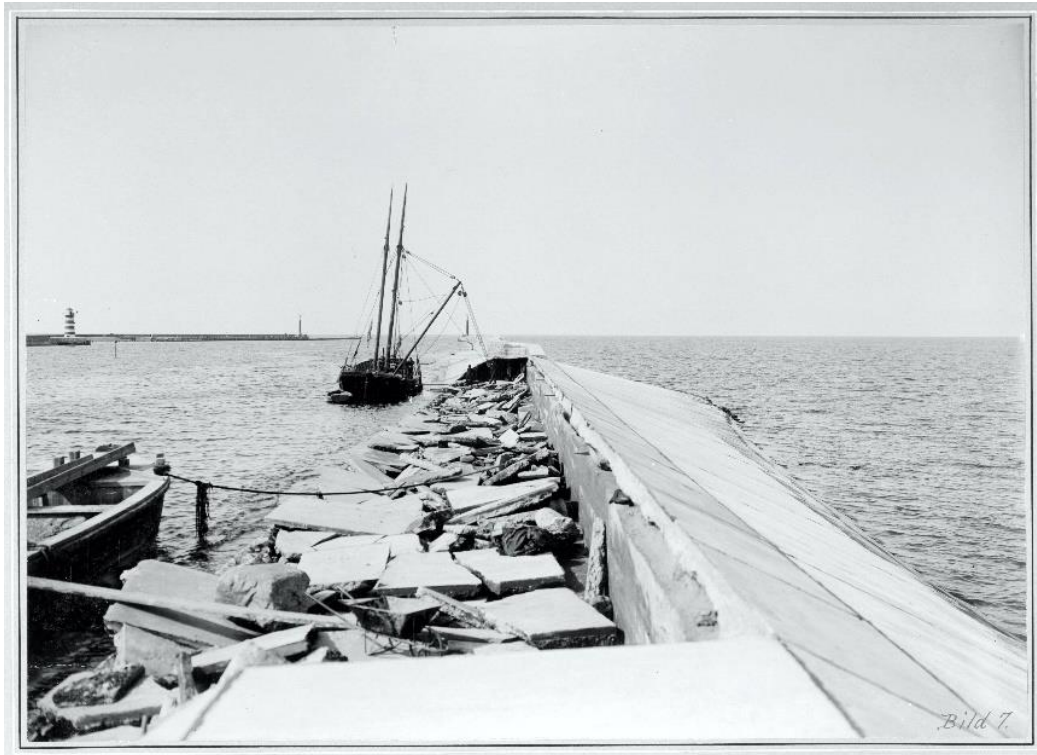
Abb. 58: Die Schäden an der Ostmole, verursacht durch das Sturmhochwasser vom 19. April 1903
