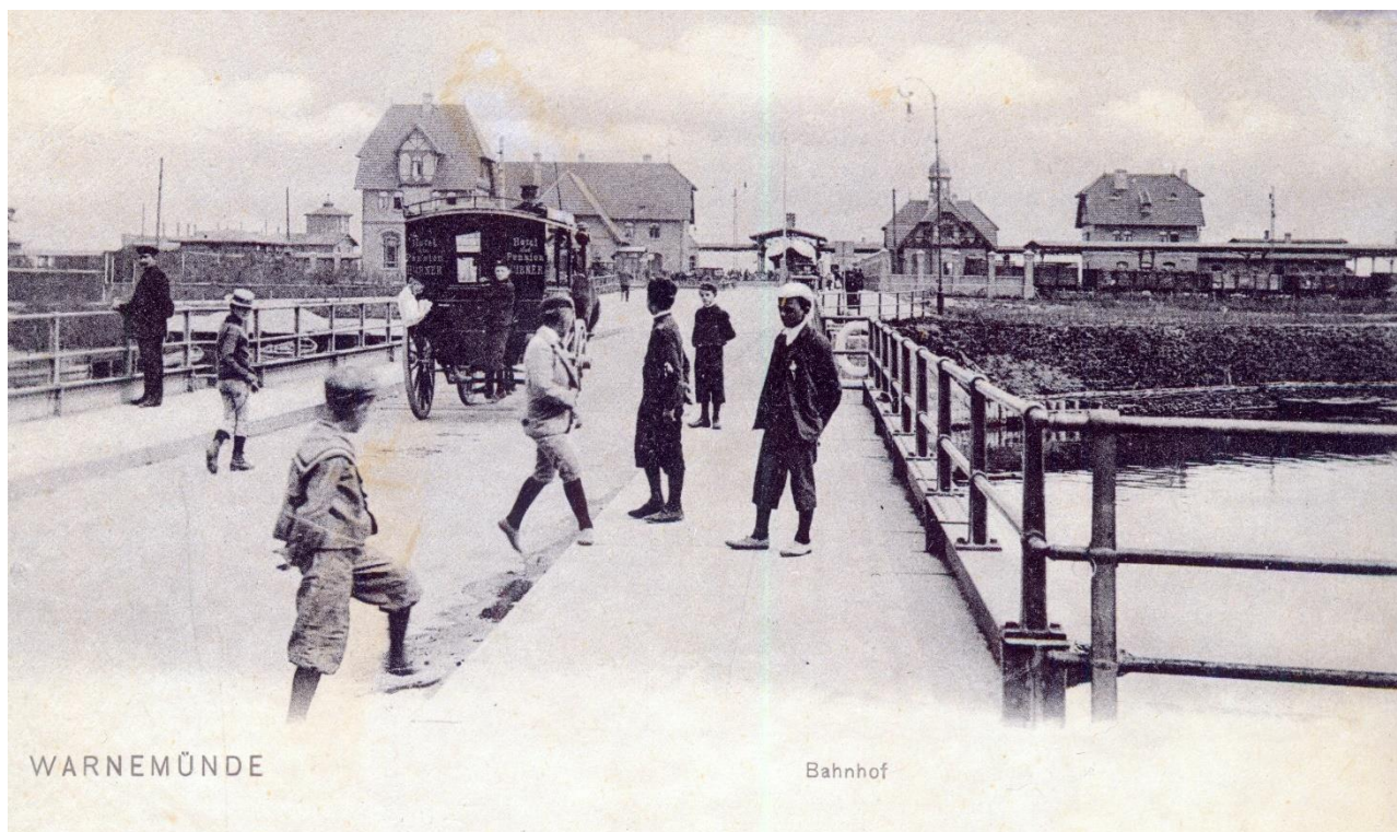
Abb. 60: Der neue Bahnhof in Warnemünde
