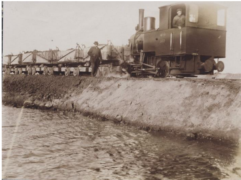
Abb. 49: Die in Dänemark geliehene Ausrüstung (Lok, 3m 3 - Kipploren)
