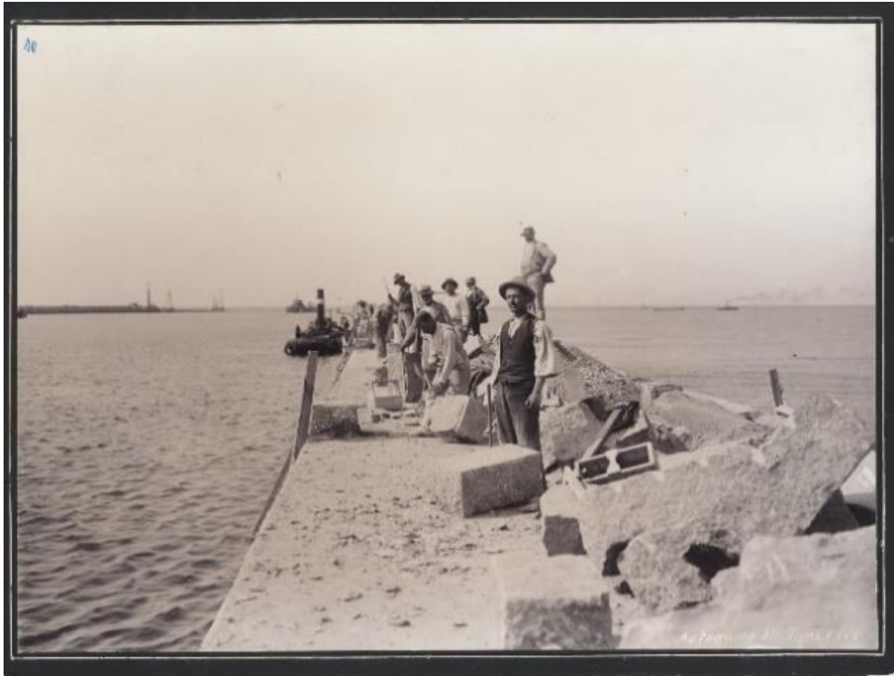
Abb. 52: Molenbau mittels skandinavischen Natursteins
