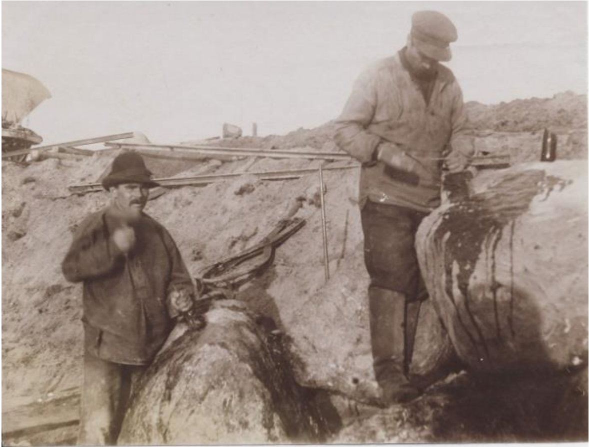
Abb. 42: Steinschläger bei den Hafengebäudearbeiten
